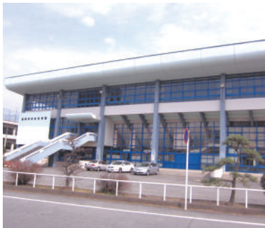
老朽化した中央体育館
