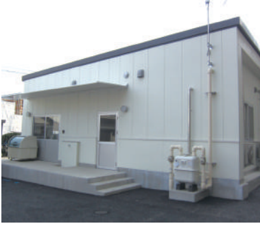
新町中学校に整備された給食室
