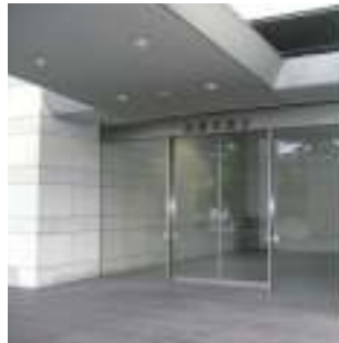
高崎市役所議会棟入口
