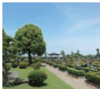
拡張工事が進む市営八幡霊園
