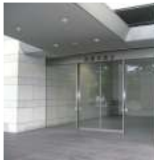
高崎市役所議会棟入口
