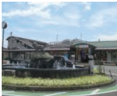
エレベーターの設置が望まれる新町駅
