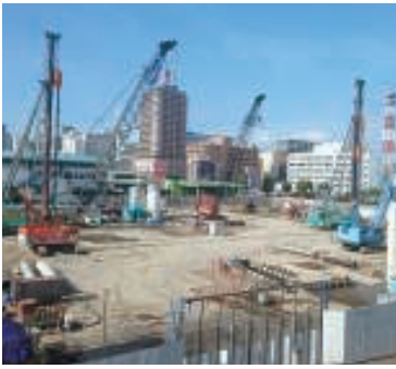
高崎文化芸術センター建設現場
