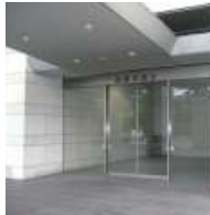
高崎市役所議会棟入口
