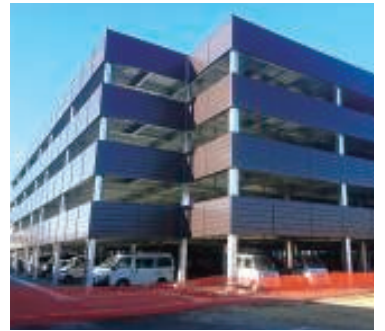
城南運動場に建設された立体駐車場
